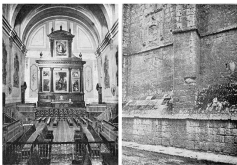
Aspecto interior y exterior de la Capilla- Paraninfo
