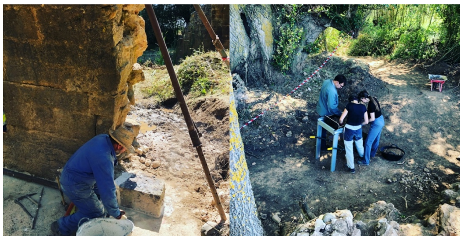
Fig. 8. A) Maestro cantero midiendo los sillares de reposición en el pilar nº 4. B) Proceso de cribado del material proveniente del estribo occidental del puente.
