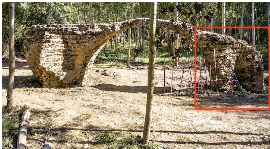
Fig. 6. Zona de intervención en el arco 5 del puente, pilar nº 4, en 2020.
