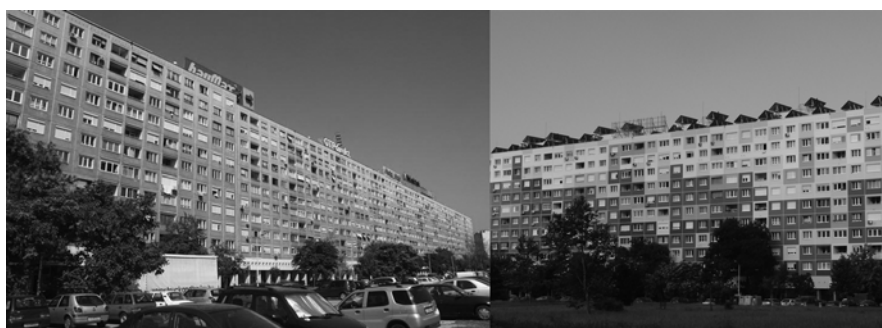
Figs. 10 y 11. El llamado “Pueblo-casa” (Faluház) en Óbuda (Budapest, Distrito III). El edificio residencial más grande de Hungría, que abarca 886 viviendas, antes y después de la renovación. Fuentes: http://epiteszforum.hu/node/13547 (Fig. 10) y foto del autor (Fig. 11)
