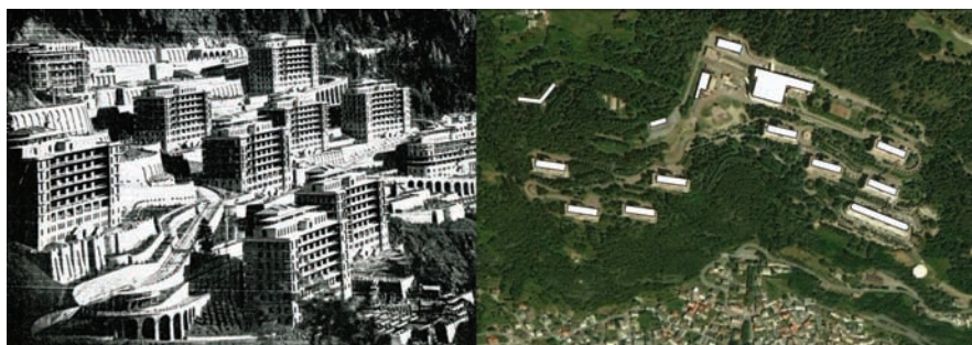
Fig. 10: a la izquierda la Ciudad Sanatorial de Sondalo, imagen de los pabellones-tipo. Fuente: B. Moretti, «Ospedali», 1940, p. 277. A la derecha la implantación actual del complejo. Fuente: elaboración propia a partir de una vista aérea procedente de Google Earth.
