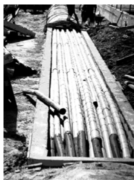
Fig.4. Ejemplo de exceso de tuberías para cableados en una canalización. Foto: Mariano Grajal.
