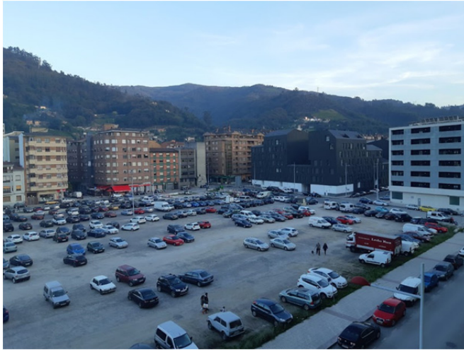
Fig. 9. Estado actual del solar de La Mayacina. Fuente: Bartolomé -dir.-, 2019.
