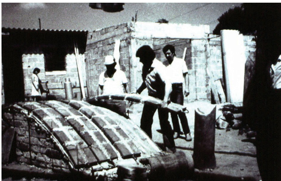
Carlos González Lobo en Tabasco, sosteniendo un elemento destinado al techo de una vivienda y demostrando que se podía prefabricar sobre el suelo.
