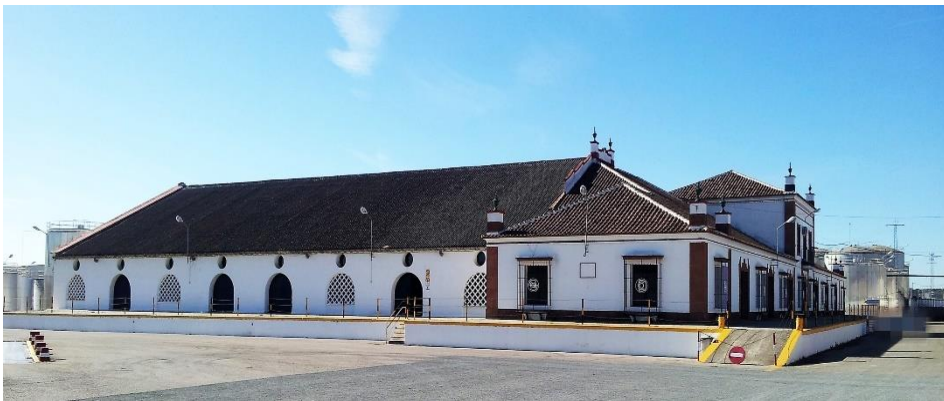
Figura 6. Almacén regulador de aceite de Montoro. (Córdoba). Exterior
