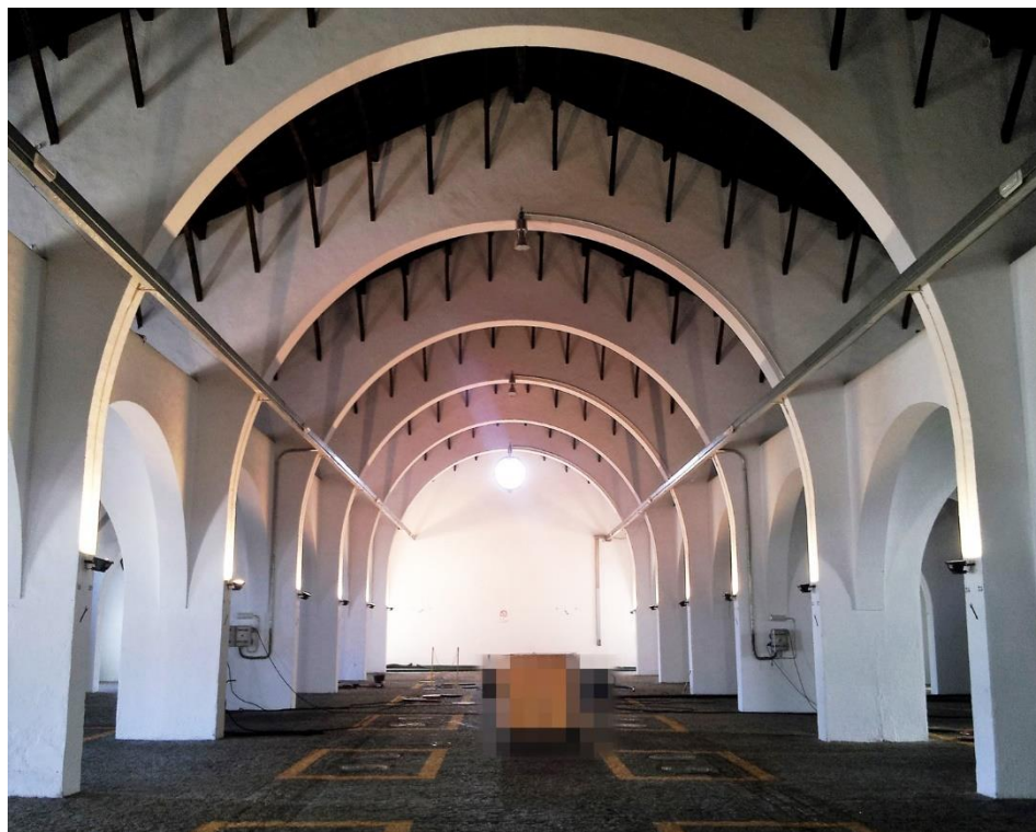
Figura 5. Almacén regulador de aceite de Montoro (Córdoba). Interior de la nave proyectada por Antonio Cámara, Rafael Cámara y José María Soroa
