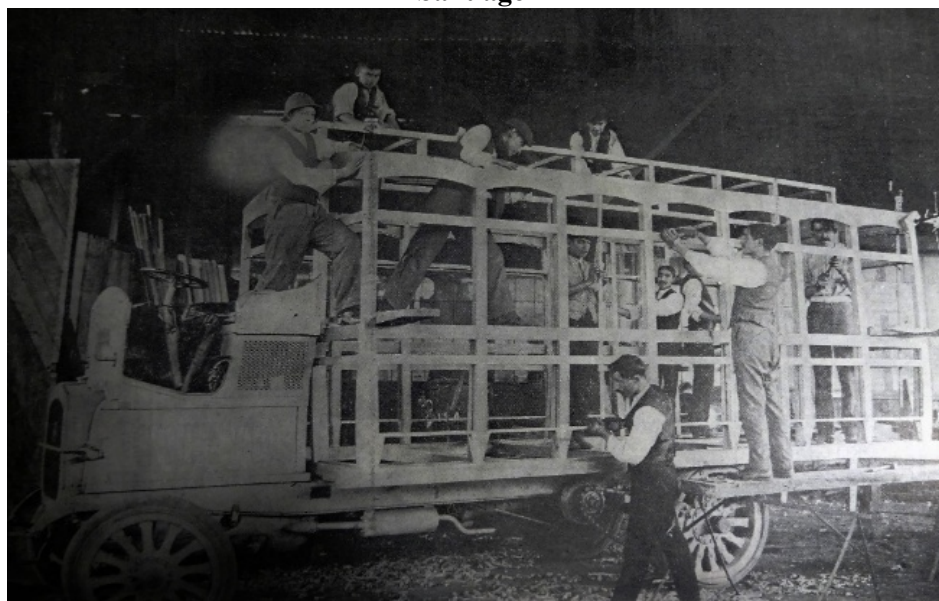
Figura 1. Fotografía retrata el trabajo en la construcción de carrocerías, realizados por los operarios de la SNAB en los talleres de Santiago.
