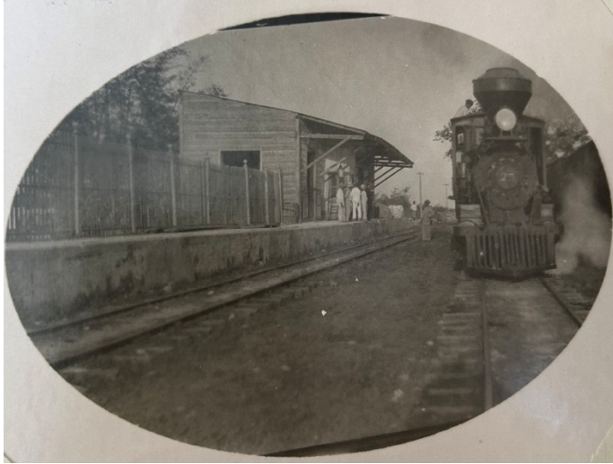
Imagen 5. Estación de Tixkokob, construcción de madera con techo de lámina.
