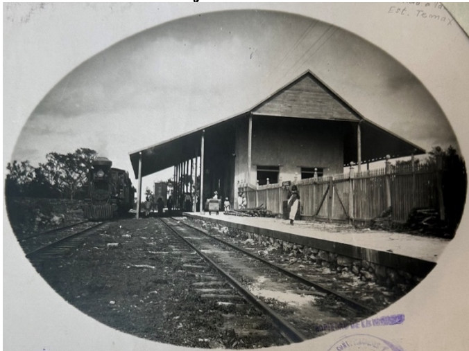
Imagen 6. Estación de Temax, construcción de mampostería con techo de tejas de barro
