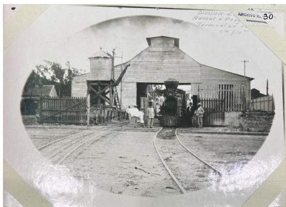
Imagen 4. Estación del Ferrocarril de Oriente en Progreso
